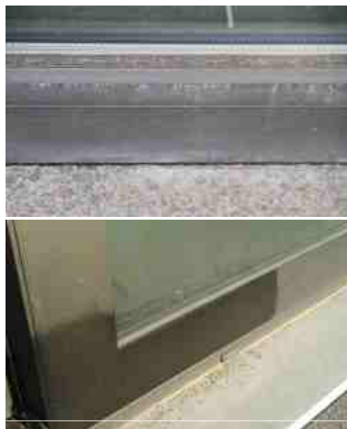
Residuen verkeerde reinigingsmiddelen (boven); voor en na de reiniging (onder); (Bron: de schrijnwerker)
